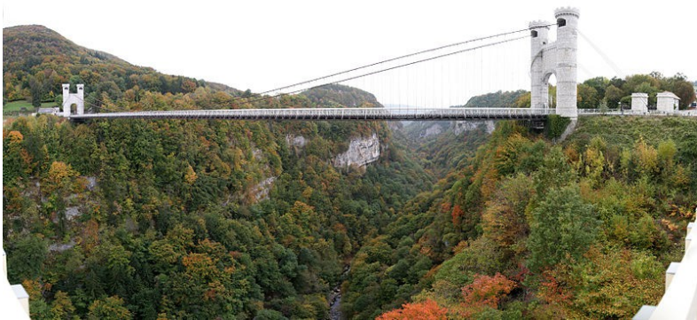
Pont de la Caille (1839) – 190 m
